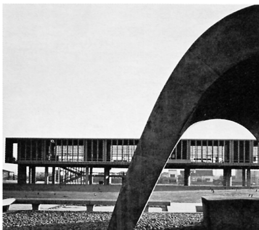
Figure 326 e 327. Ponte della Pace, balaustra in calcestruzzo a forma di ‘fungo’, I. Noguchi; K. Tange, Edificio del Museo: vista dal Monumento commemorativo.
