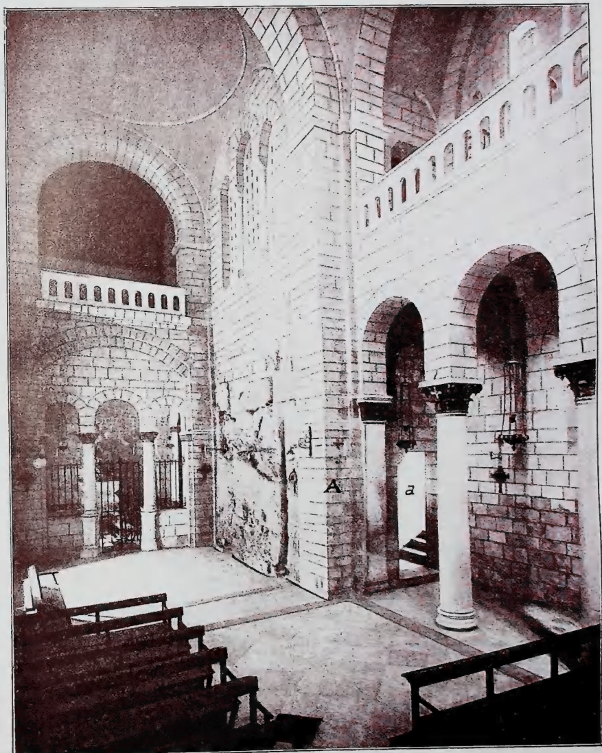
Basilica dell'Ecce Homo: A, pilastro nuovo; a, piccolo corridoio di accesso alla Basilica. In fondo al narthex uno zoccolo antico preso dal lithostroto.
