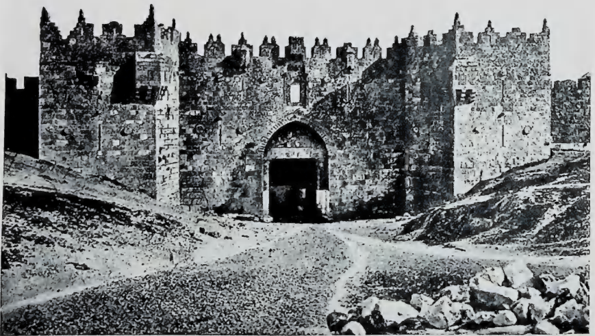
Porta di Damasco (Fot. Brogi).
